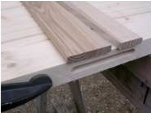
Photo 1 Deux éléments d'une clé, prêts à être enfoncés
