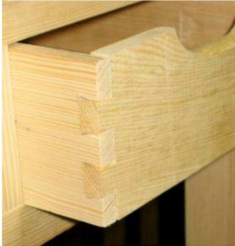
Les queues d'arondes ont été réalisées avec une défonceuse équipée d'une fraise à queue d'aronde. J'ai utilisé le gabarit que j'ai réalisé sur la base du plan fourni par Jean Marie du Berry sur son site. Merci !
