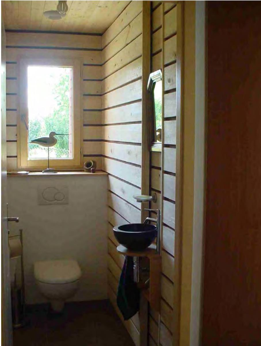
A la fin de la construction, il me restait quelques m<sup>2</sup> de volige en peuplier de 2.50 m en section 150x18 mm. J'ai pensé les utiliser en décoration intérieure. J'ai donc réalisé, à titre expérimental, un habillage de mur de WC, les lames étant posées horizontalement. Le résultat était satisfaisant. J'ai poursuivi l'expérience sur un mur plus important, en modifiant le sens de pose des lames qui dans ce dernier cas sont posées verticalement
