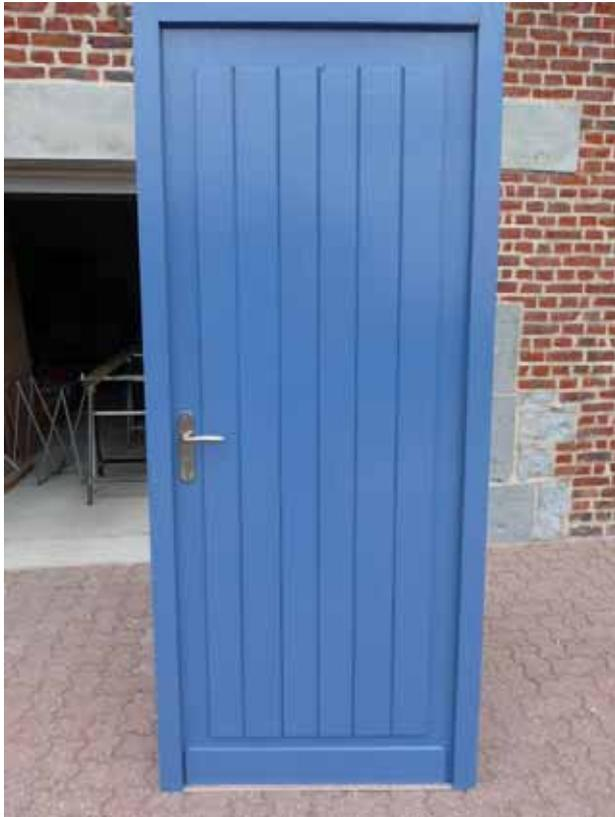
Une porte de service (garage/jardin) qui est exposée parfois à la pluie. J'ai donc voulu éviter les panneaux mis dans des rainures. La façade de la porte devait ressembler à celle des volets extérieurs. J'ai donc réalisé des lames à volets en utilisant les fers montés sur un PO de 50 mm de hauteur. Dimensions tableau : 905 sur 2120
