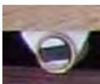
Si, pour les portes, vous utilisez ce type de fermeture magnétique, pensez à réaliser une petite découpe en arrondi à l'arrière du tiroir du haut. Sinon, il risque de ne pas passer.
