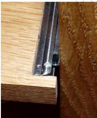
Une découpe réalisée à l'avant du plateau permet de cacher la glissière.
