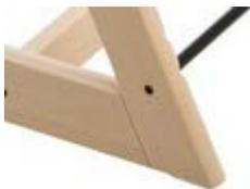
Pour la fixation des montants, j'ai opté pour un autre assemblage que celui de la « trip trap » car j'avais peur de ne pas faire quelque chose d'assez solide et je ne voulais pas mettre de vis apparentes.
