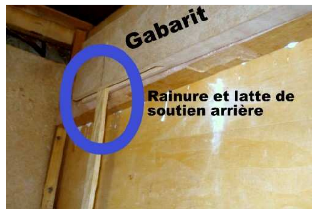
Le bout de latte qui soutient le gabarit à l'arrière
